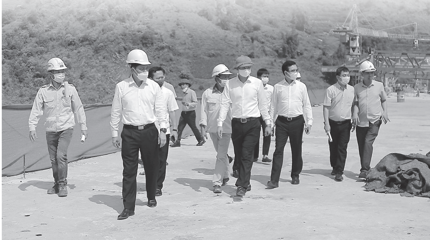
Thủ trưởng Bộ GTVT Nguyễn Ngọc Đông kiểm tra tiến độ thi công dự án cầu Móng Sến
