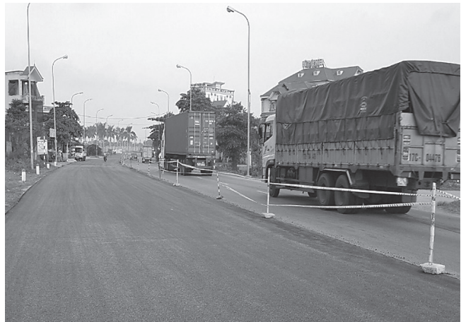
Thi công thử nghiệm mặt đường bê tông nhựa ấm
