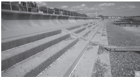
Hình 2.4: Mái nghiêng bậc thang có tường hắt sóng tại Cleveleys (Anh)
