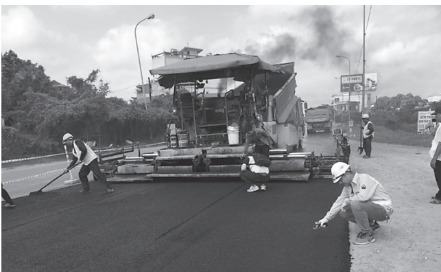
Đoạn đường thử nghiệm và thiết bị chế tạo trong nghiên cứu công nghệ thích hợp phục vụ xây dựng đường giao thông nông
