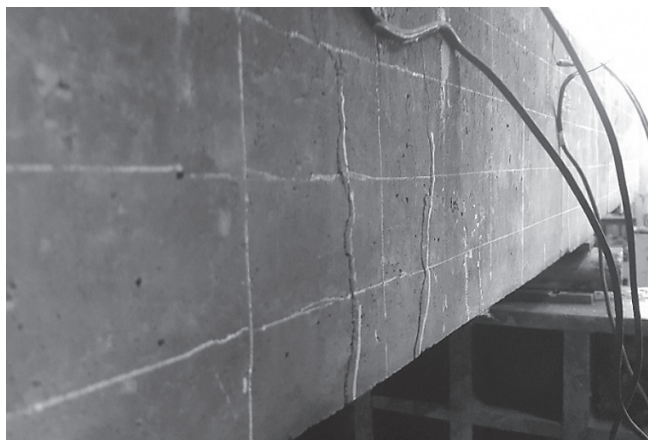
Nghiên cứu ứng dụng vật liệu FRP trong sửa chữa, nâng cấp cầu BTCT
