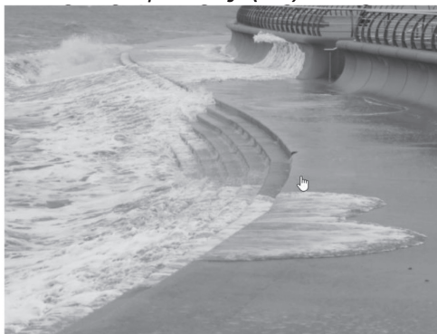
Hình 2.5: Mái nghiêng bậc thang kết hợp thêm giảm sóng và tường hắt sóng tại Blackpool (Anh)
