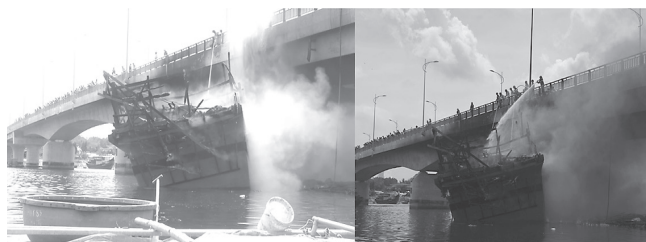
Hình 3.1: Hiện trạng cháy tàu cá tại khu vực trụ T4 cầu Trà Bồng
