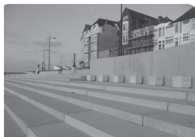
Hình 2.3: Mái nghiêng bậc thang có tường đỉnh Magrate (Anh)
