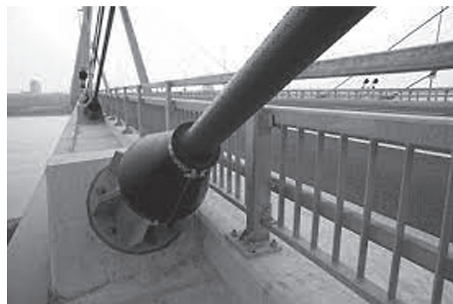
Hình 1.1: Vùng neo cáp trong cầu dây văng
