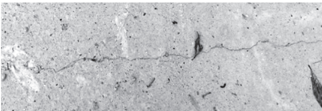
Hình 3.2: Vết nứt xuất hiện trên bề mặt tấm BTXM sau 3 tháng thi công
