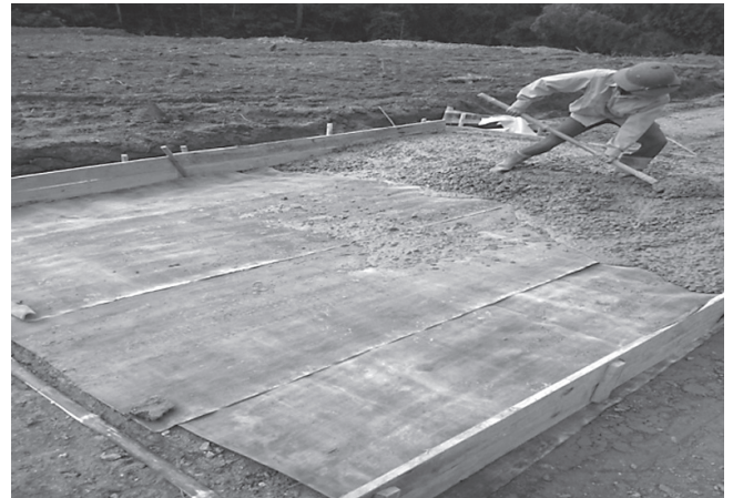
Hình 2.3: Quá trình thi công tấm tại hiện trường
