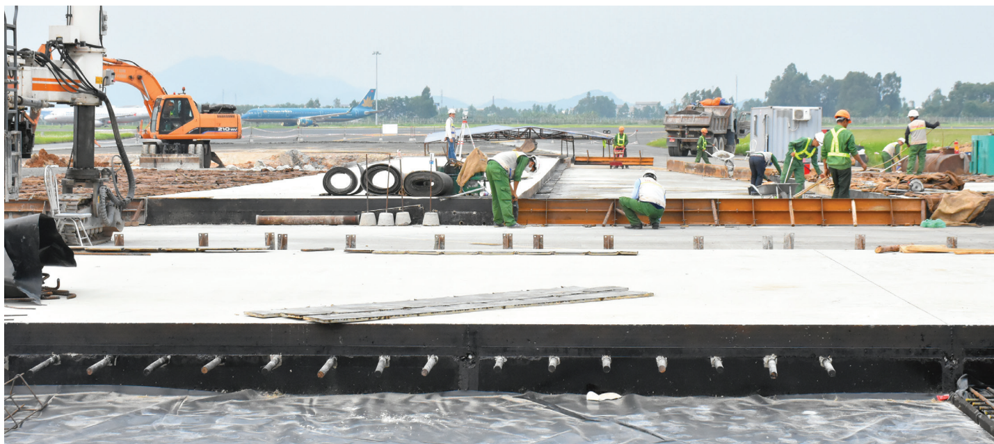
Thi công sửa chữa đường băng, đường lăn Cảng Hàng không quốc tế Nội Bài
