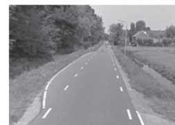
Hình 2.4: Làn phụ vượt xe trên đường GTNT
