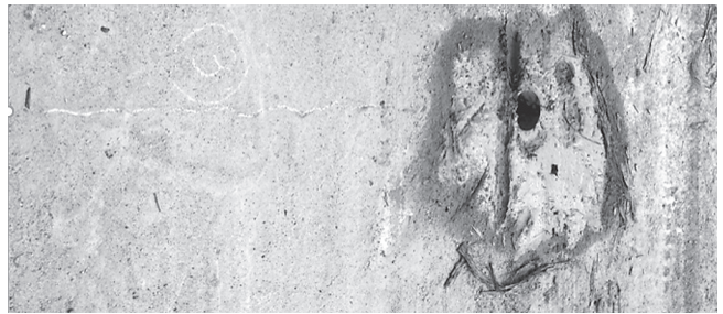
Hình 3.3: Khoan lấy mẫu tại vị trí xuất hiện vết nứt ngang trên bề mặt tấm BTXM
