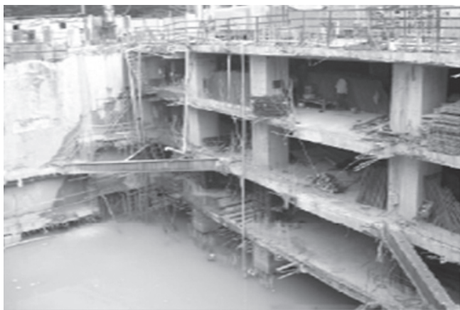
Hình 1.1b: Sự cố sập công trình lân cận khi thi công tầng hầm tòa nhà Pacific - số 49 Nguyễn Thị Minh Khai - TP. Hồ Chí Minh năm 2007
