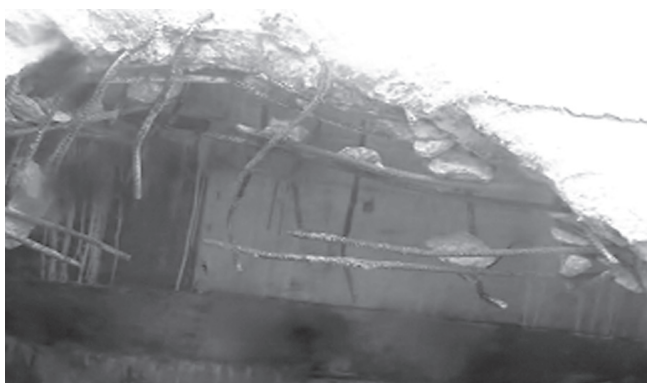
Hình 4.4: Vị trí số 2 bị hư hỏng nghiêm trọng sau sự cố đâm va
