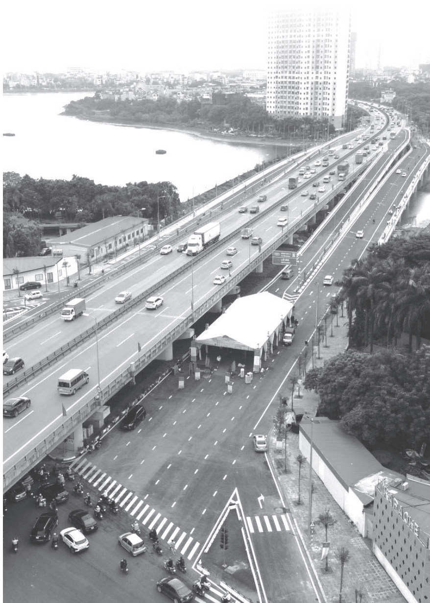
Cầu qua hồ Linh Đàm và nhánh kết nối đường Vành đai 3 trên cao
