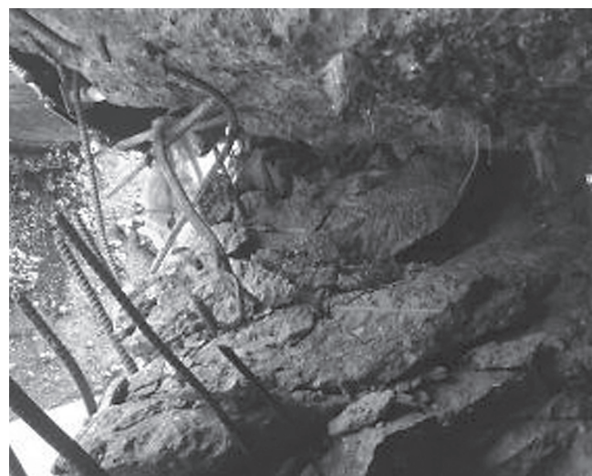
Hình 4.3: Vị trí số 1 bị hư hỏng nghiêm trọng sau sự cố đâm va
