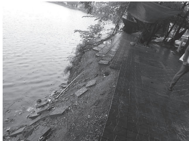
Hình 1.1: Kè hồ bằng tường chắn bị mất ổn định
