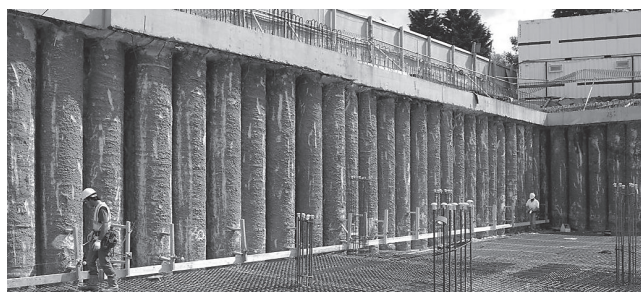
Hình 1.3b: Sử dụng cọc khoan nhồi đường kính lớn làm tường chắn đất trên thế giới
