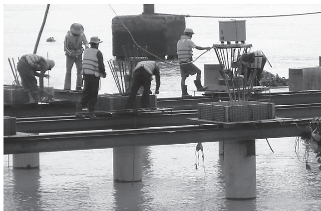
Hình 2.1: Thi công cảng biển
