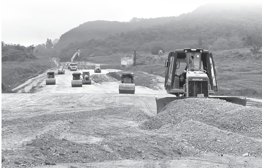
Cao tốc Bắc - Nam đang được gấp rút thi công
