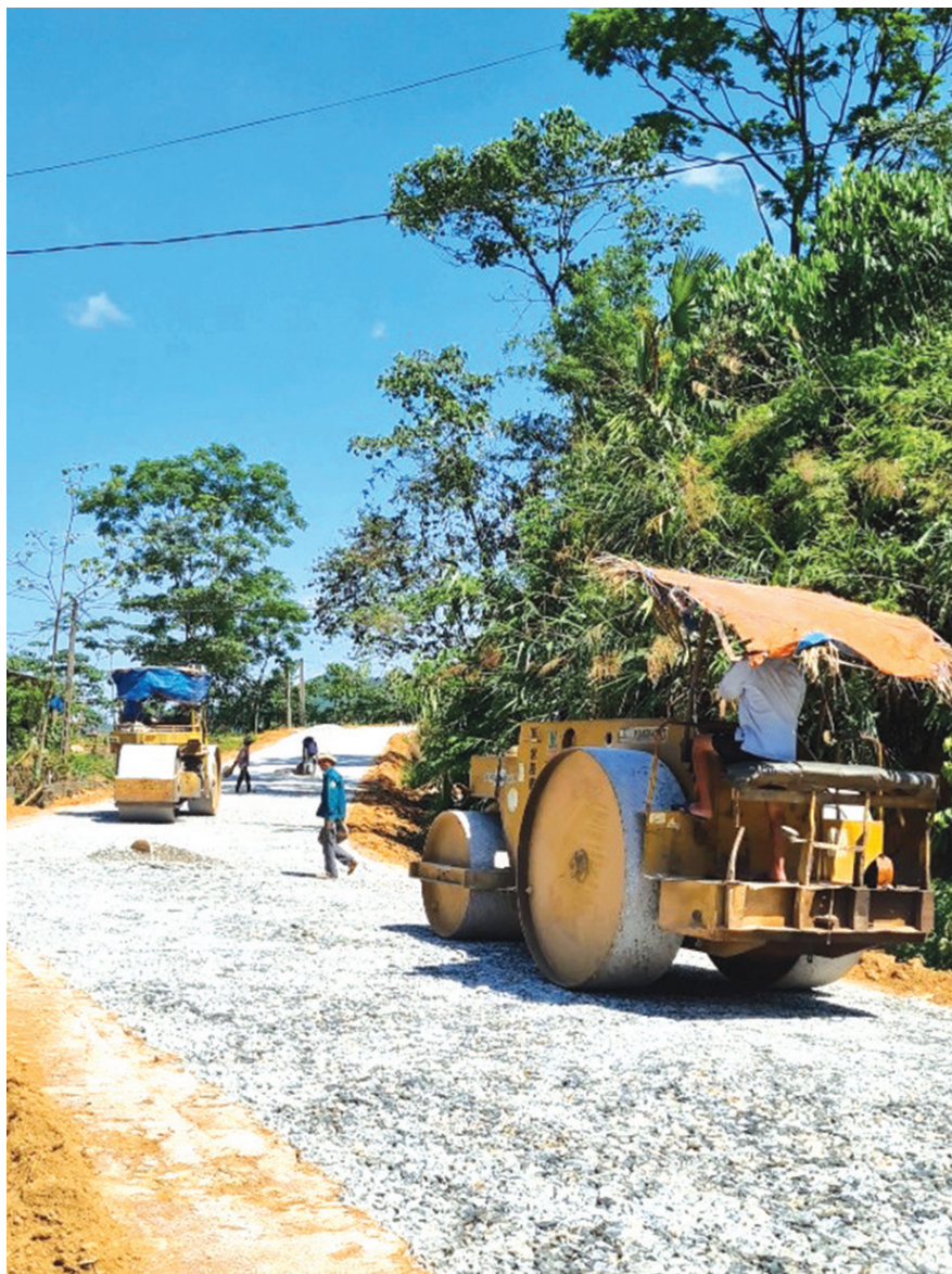
Công trường sửa chữa định kỳ đường Mậu A - Tân Nguyên (Đường tỉnh 165)
