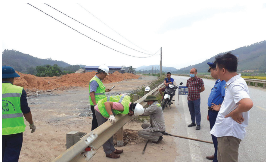
Rào lại hệ lan bị tháo dỡ trên QL32C
