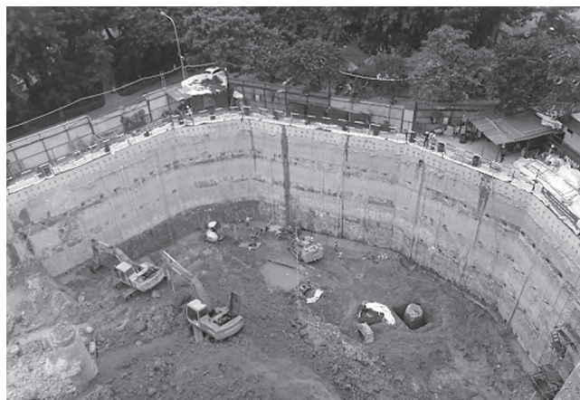
Hình 1.2b: Sử dụng tường barett làm tường chắn giữ ổn định thành hố đào khi thi công phần ngầm
