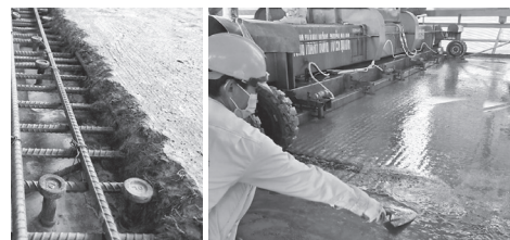
Hình 2.9: Sửa chữa mặt cầu Thăng Long bằng UHPC
