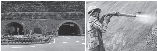
Hình 2.6: Sửa chữa hầm đường bộ Hải Vân
