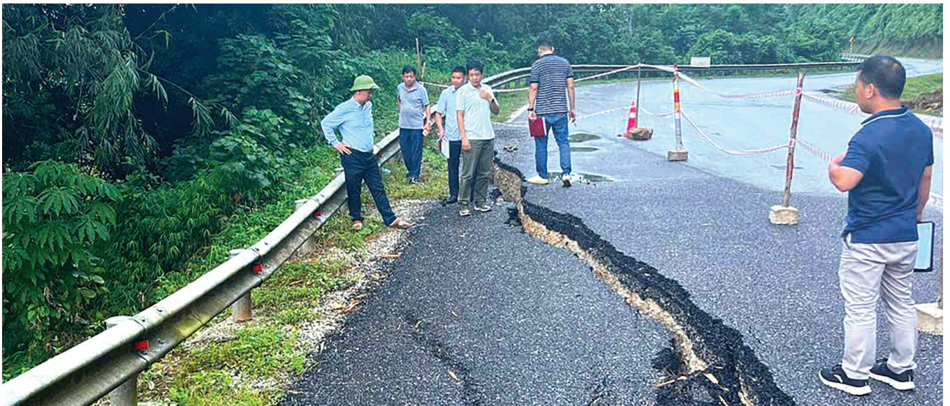
Sạt lở ta-luy âm gây sụt nền đường tại QL4A qua tỉnh Lạng Sơn
