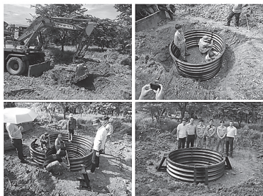
Hình 3.2: Thi công phần đỉnh hố đào và lắp ráp 3 vòng đầu tiên
