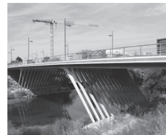
Hình 2.4: Xây dựng cầu André Lévy ở Pháp
