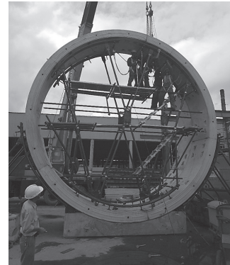
Hình 3.1: Vỏ hầm tuyến hầm metro số 1 TP. Hồ Chí Minh Bến Thành - Suối Tiên
