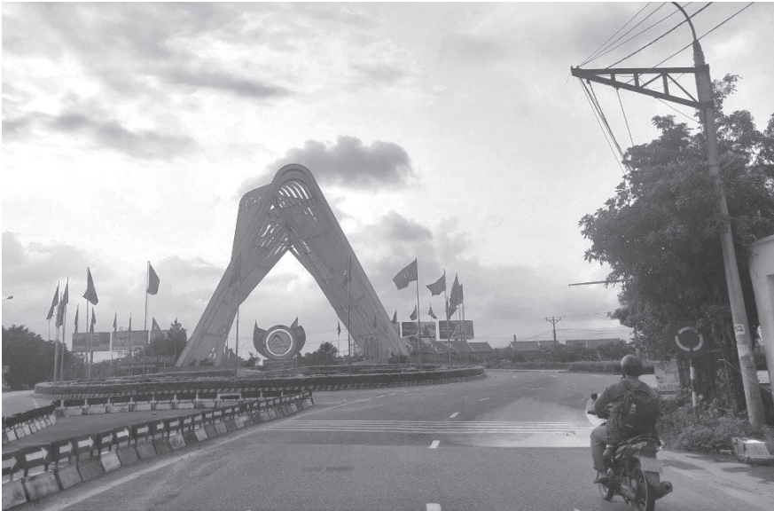
Một nút giao trên QL18 thuộc địa phận tỉnh Quảng Ninh
