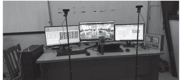
Hình 4.1: Phần cứng hệ thống báo cháy
