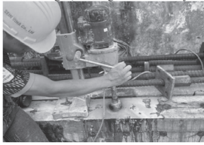
a) - Khoan lấy mẫu bê tông
