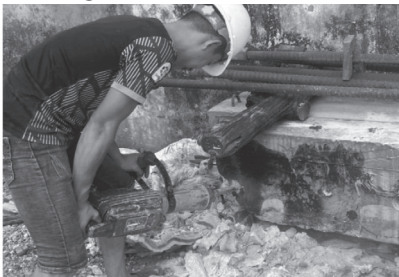
a) - Đục bỏ dầm để cắt cáp DUL
