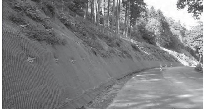
Hình 2.2: Ổn định mái dốc bằng lưới thép cường độ cao, neo đất và vải địa kỹ thuật tổng hợp
