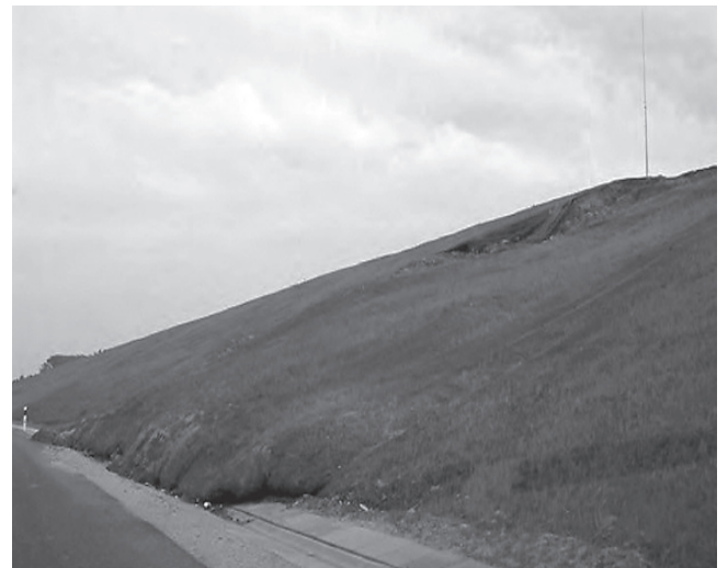
Hình 1.2: Mái dốc có góc dốc 25 độ, kết hợp giữa vải địa kỹ thuật và lưới thép cường độ cao
