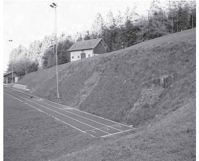
Hình 1.1: Mái dốc tại trường thực tập (Nguồn ảnh: Geobrugg AG)
