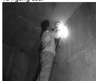
a) - Lắp đặt thiết bị đo ứng suất dầm hộp
