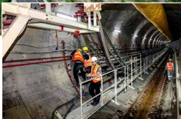
Máy TBM được thiết kế riêng cho dự án tuyến đường sắt đô thị số 3, đoạn Nhổn - Ga Hà Nội với công nghệ hiện đại và độ chính xác cao.
