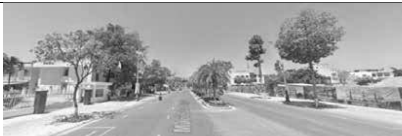
Tuyến đường 16/4 (xây dựng năm 2005)
