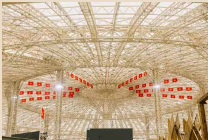
Phần mái vòm đồ sộ với hệ số an toàn gấp đôi thông thường, kết hợp vật liệu xuyên sáng đạt chuẩn kiến trúc xanh toàn cầu.
