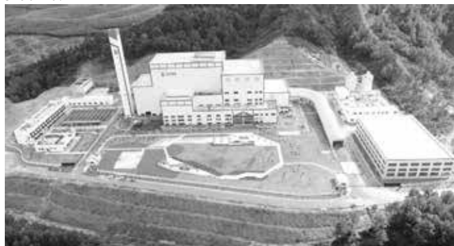
Hình 5. Toàn cảnh Nhà máy điện rác Phú Sơn, TP Huế [9]
