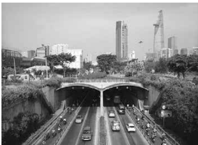
Hình 4. Đường hầm Thủ Thiêm TP.HCM hiện nay
