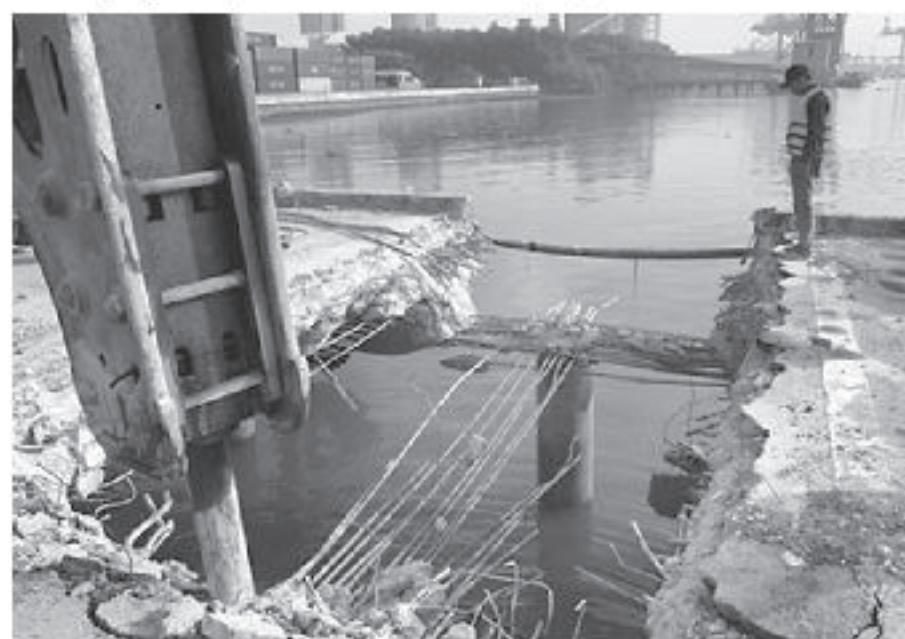
Hình 3.1: Công tác phá dỡ bắn mặt cầu và đầm để thử nghiệm PDA cọc C1 và C2 [2]
